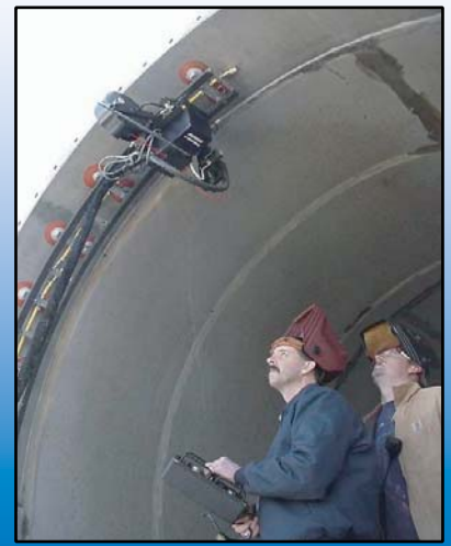
Pipeliner monté sur Flix-track - Soudage intérieur d'une virole 3,3 m en inox.
