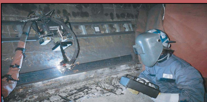
Robe de Ø 15,2 m - Soudure extérieure sur chantier - Raffinerie Canada
