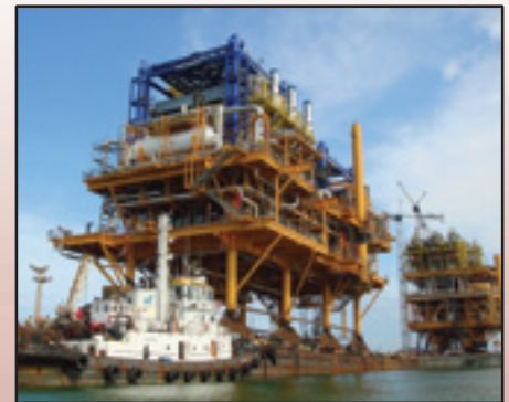
Plateforme Offshore - Swecomex, Mexique
